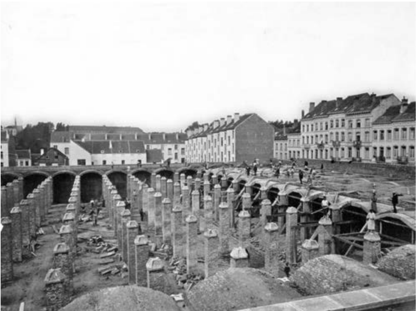
Bouw van een waterreservoir van 20.000 m 3 in Elsene, augustus 1877 (ASB CI J-694).
