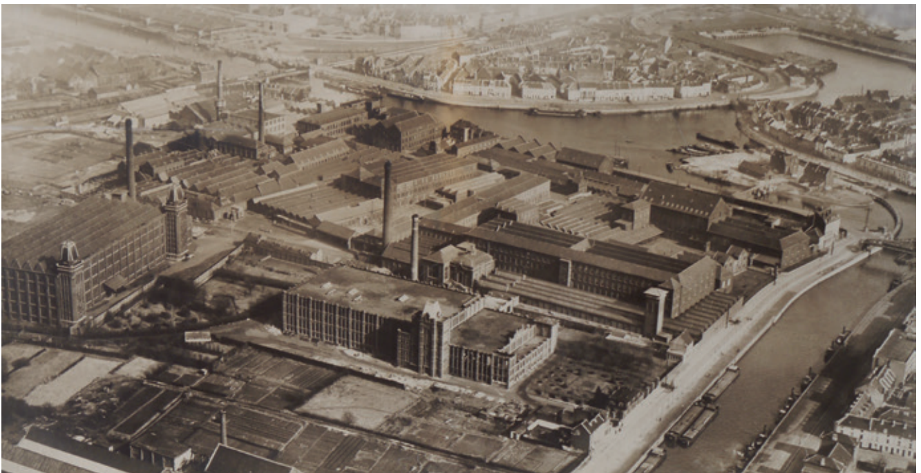
Luchtopname Vynckier in Gent. Op enkele gebouwen rechtsboven na palmt het bedrijf de volledige site in beeld in. (Collectie Industriemuseum F10185).
