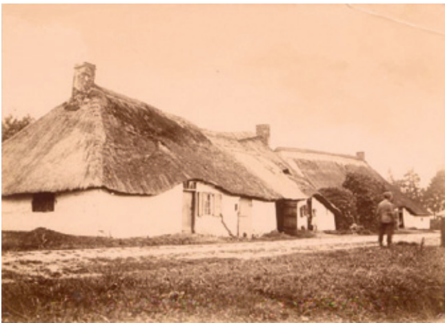
Foto van een traditionele Kempische hoeve te Dessel. De hoeve bestond uit lemen muren en had een dak van stro. Het woonhuis en de stallen waren samengevoegd. (begin 20 ste eeuw). http://www.erfgoedbanknoorderkempen.be/erfgoed/6834-hoeve-dak-van-stro-en-lemen-wanden-woonhuis-en-schuur
