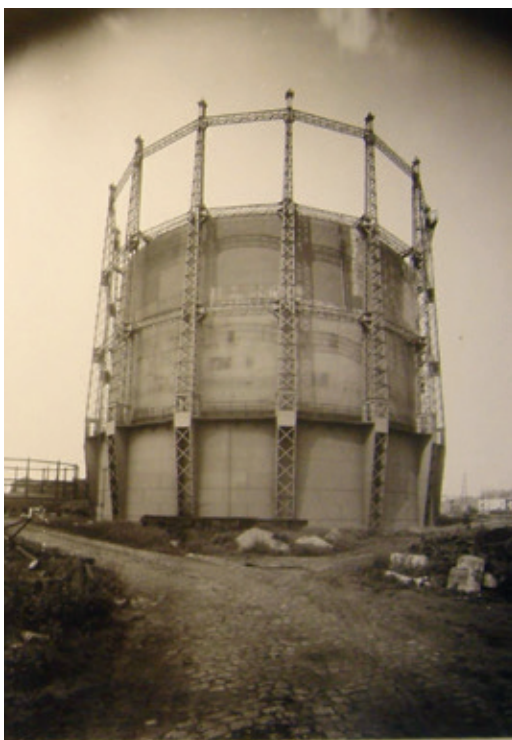
Gashouder (gasmeter, gazometer, in gevulde toestand) van het stedelijk gasbedrijf aan de Gasmeterlaan (foto 1943, Stadsarchief Gent, fotoverzameling Stedelijke Commissie voor Monumenten en Stedschoon nr. 7371).
