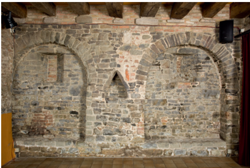
De Oude Steen , Wollestraat 29–31, © Dienst Monumentenzorg, Stad Brugge. De Oude Steen is de oudst gedocumenteerde stenen woning in Brugge, gedeeltelijk opgetrokken in veldsteen. In de zijgevels van de kelderderdieping zijn nog duidelijk de spanningsbogen te zien die de druk boven de kijksteuven wegnamen. Die openingen waren in een latere fase dichtgemetseld, vermoedelijk toen deze aanvankelijk vrijstaande woning een rijwoning werd. De driehoekige nis centraal op de foto is een kaarsnis die voor bijkomende verlichting moest zorgen.
