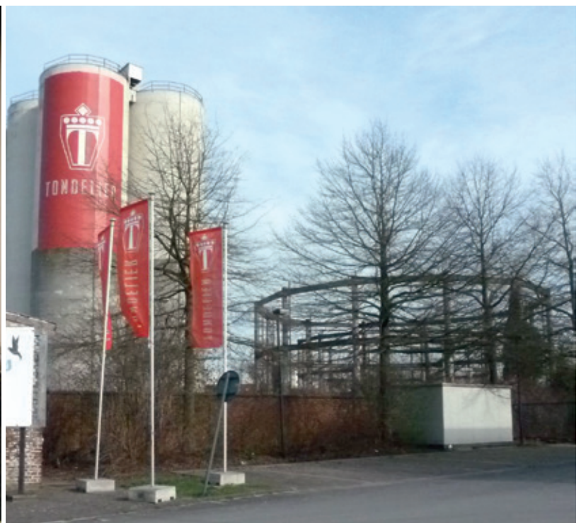
Zelfde gashouder of 'gasklok' (foto 2015) met publiciteit voor het project woonpark Tondelier. De tank (rechts) is leeg; hij is volledig onderaards gezakt in een reusachtig waterreservoir, eigen aan dit type 'natte' gashouders. Bij vulling met gas wordt de gashouder omhoog gestuwd zoals op de afbeelding hiernaast te zien is. De dichting van deze reusachtige 'klok' zonder bodem wordt verzekerd door een watermantel op de bodem en er omheen tot op het maaiveld. De inhoud wordt 'gemeten' aan de hand van de hoogtestand: vandaar de termen gazometer, 'gasmeter' en Gasmeterlaan.
