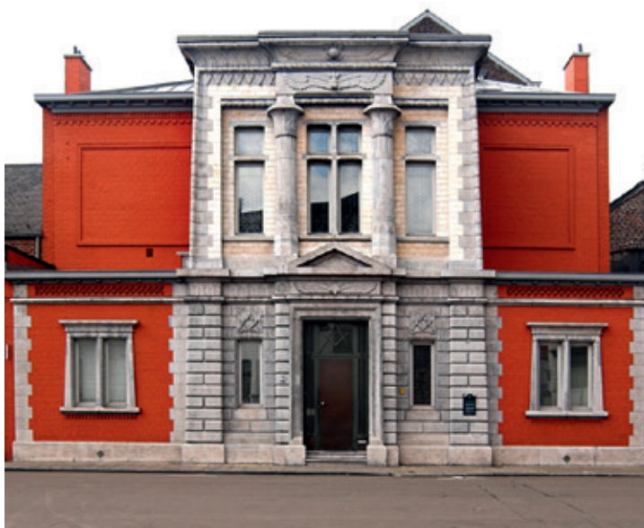
Voorgevel van het logegebouw van La Parfaite Union in Bergen. Foto Wikimedia. Licensed under CC BY 1.0 via Wikimedia Commons
