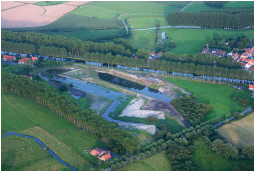
Luchtfoto van de stadswallen van Damme, site Oude Schaapskooi, tijdens de uitvoering van de werken in 2007. © Lieven Vergauwen
