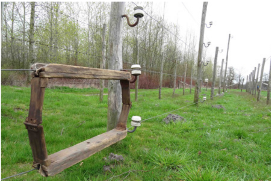
Met een passeurs- of vouwraam, ook plooi kader genoemd, konden ervaren passeurs door de versperring glippen. Bovenaan en onderaan waren gleufjes gemaakt, met isolerend materiaal, om het passeursraam vast te zetten tussen twee stroomdraden. Dit origineel passeurskader steekt hier tussen de draden van de zeer voortreffelijke en historisch correcte reconstructie in Zondereigen, een gehucht van Baarle-Nassau (Foto Herman Janssen, Merksplas; het raam is eigendom van de Heemkundige Kring Marblas, Merksplas).
