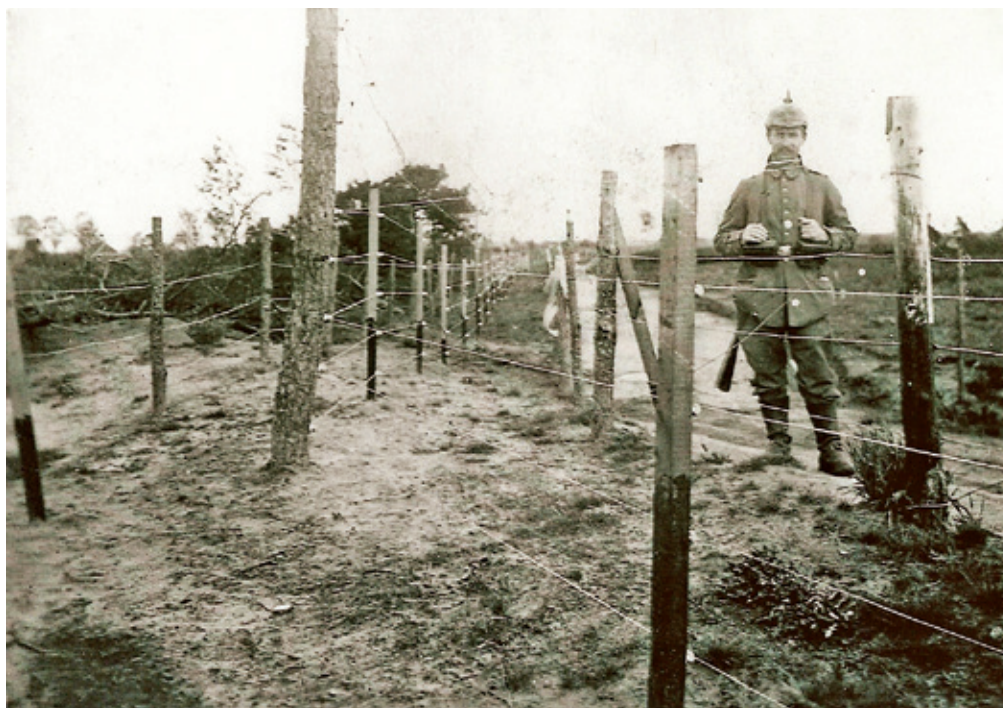
De versperring bij Wortel Kolonie. Het betreft hier een stuk versperring in standaarduitvoering, met vijf gladde draden. Het was de Duitse grenswachters geraden om niet tussen de draden te lopen. Zij moesten op het patrouillepad blijven, dat overigens zo goed als altijd aan de Belgische kant van de versperring lag (Collectie Herman Janssen, Merksplas).
