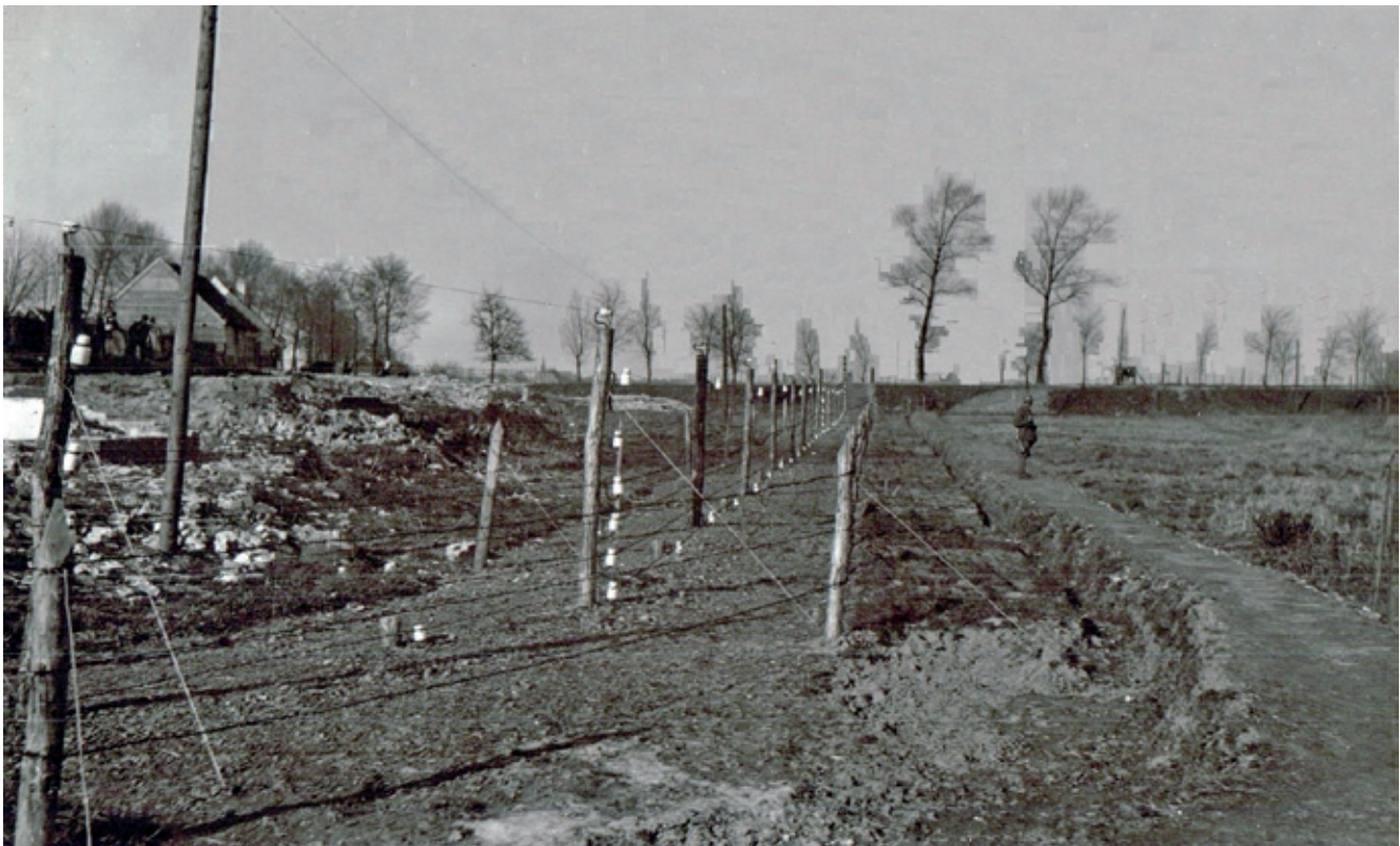
De draadversperring aan de Posthoorn bij Boekhoute. Men onderscheidt duidelijk de drie versperringen, met in het midden de draden, bevestigd aan de porseleinen isolatoren, waar een spanning van 2000 volt op stond. Rechts ligt het patrouillepad, altijd aan de Belgische kant van de versperring, met een grenswachter. Omdat dit een gebied was dat regelmatig kon overstromen, werd het patrouillepad enigszins verhoogd (Foto archief Alex Vanneste).
