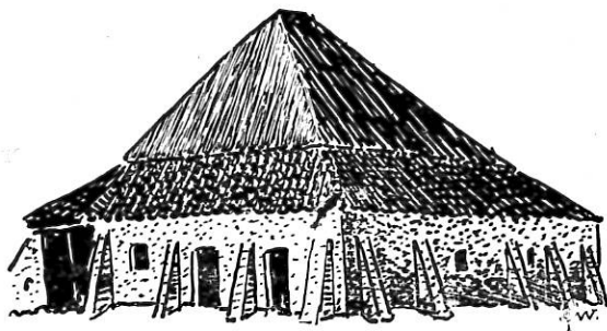
Bergschuur uit Zevokote. Wellicht gebouwd door de benediktijnermonniken van St.-Andries?
