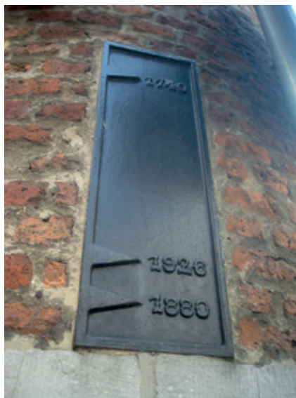
Vloedmerk op de hoek van de Rue Saint-Nicolas en de Rue du Tan voor de jaren 1740, 1926 en 1880. In 1740 werd de hoogste waterstand gemeten. Zeer waarschijnlijk is deze twintigste-eeuwse plaat gebaseerd op oudere merken. (Bron: www.panoramio.com/photo/53692621 )
