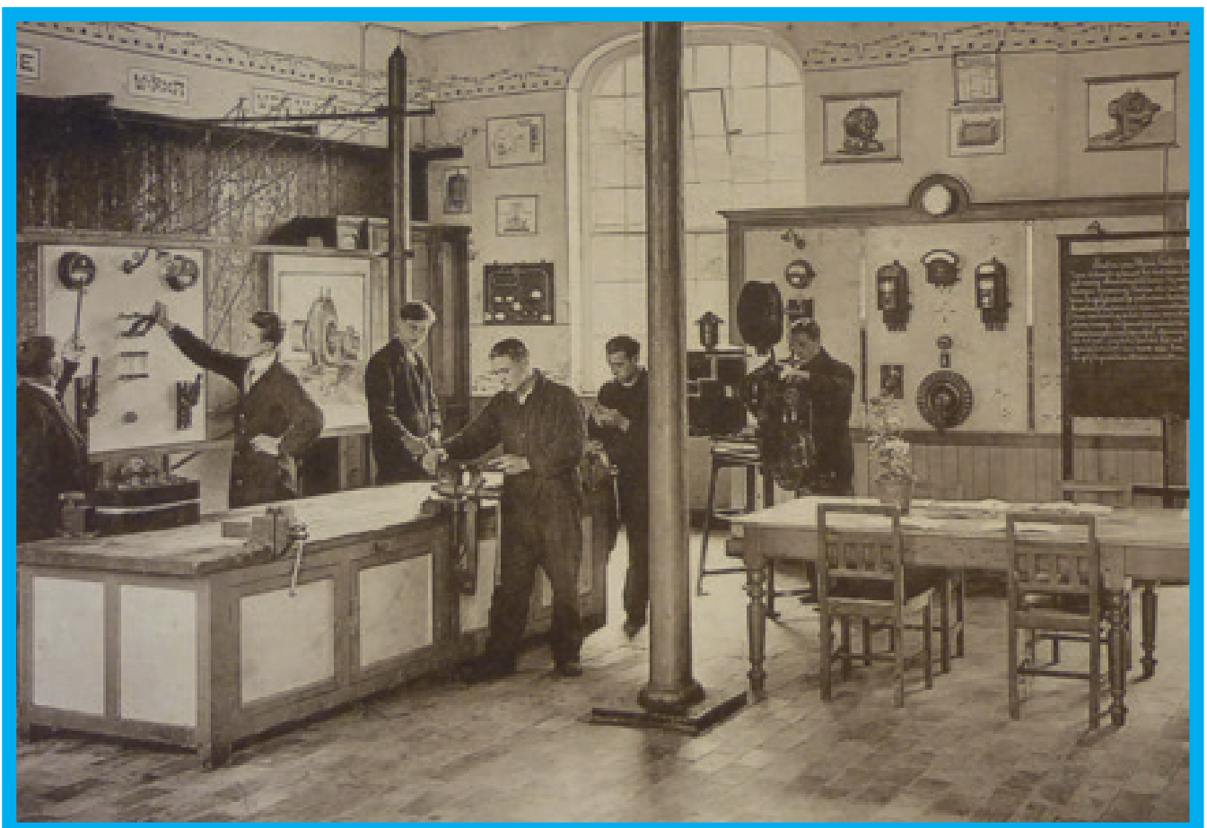
Het elektriciteitswerkhuys in het Rijksopvoedingsgesticht Ruiselede, ongedateerd maar vermoedelijk uit de periode van het interbellum. Bron: RAB, M37, ROG 1992, nr. 228.
