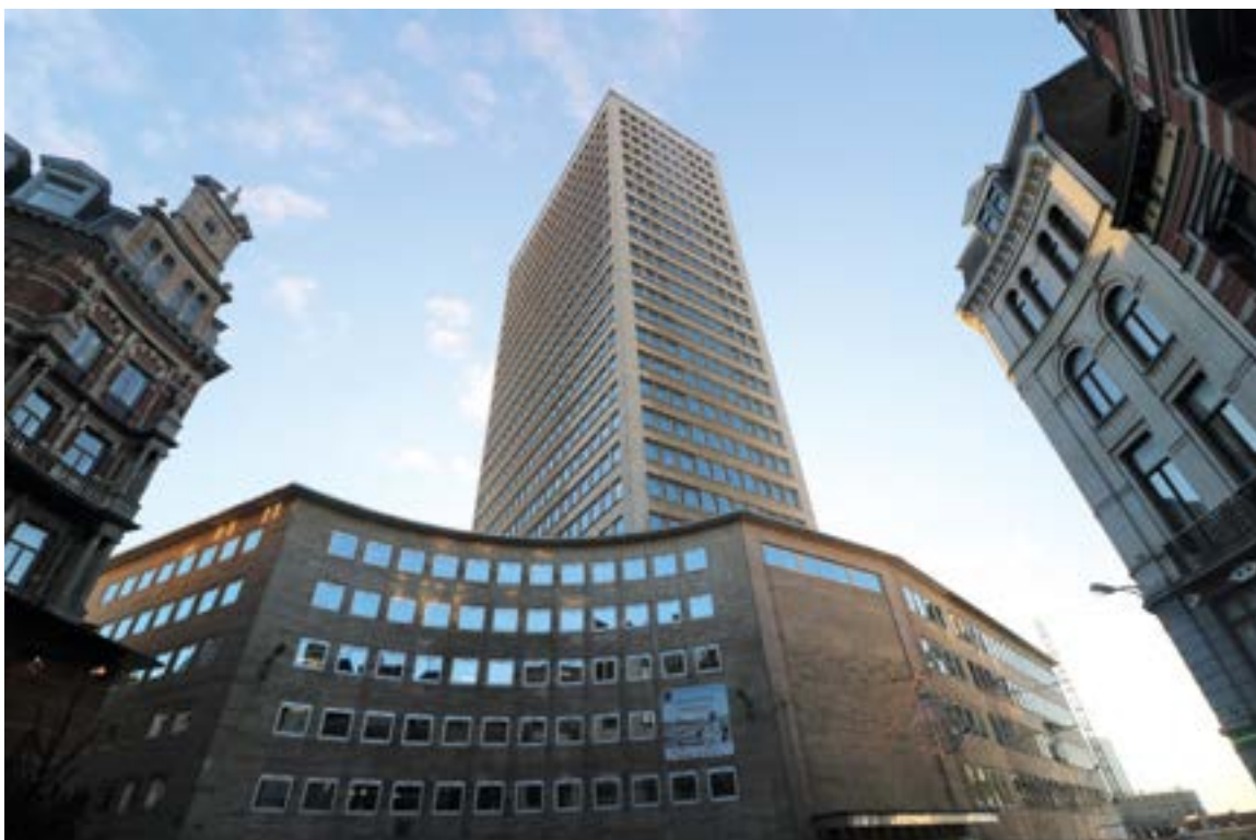
De Zaveltoeren in Brussel, gebouwd in 1965 ter vervanging van het gesloopte volkshuis van Victor Horta. De informele naam 'Tour Bilton' verwijst naar de aannemer die de toren heeft opgetrokken. – Matthijs Degraeve 2018.
