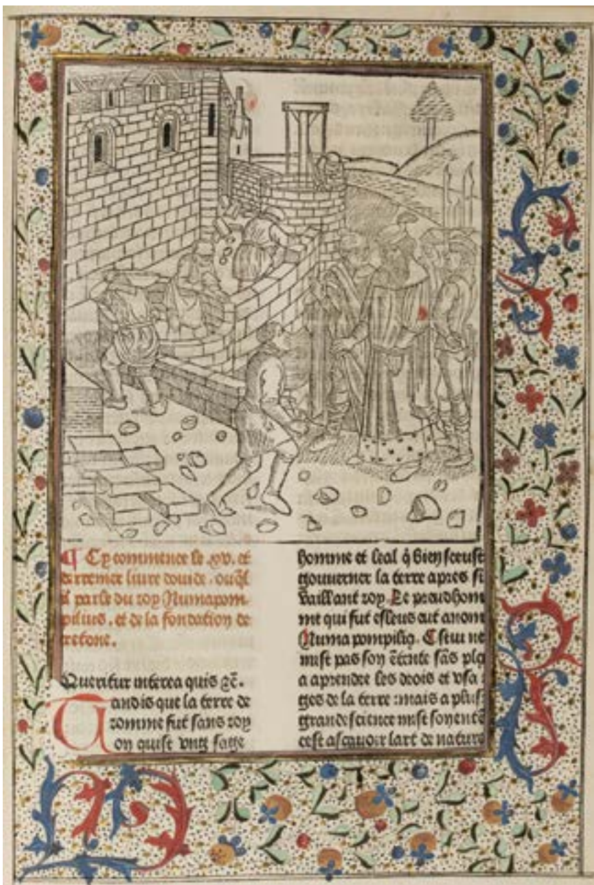
Laatmiddeleeuwse bouwwerf, houtsnede uit Colard Mansions Ovide Moralisé : de stichting van Crotona (1484) (Brugge, Openbare Bibliotheek, Inc. 3877, f°372)
